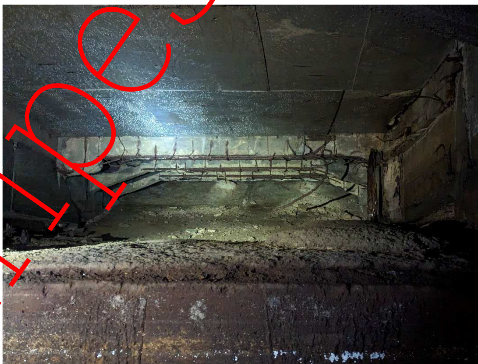
Foto 10. Serie de antretoaze cu armaturile expuse, ruginite
