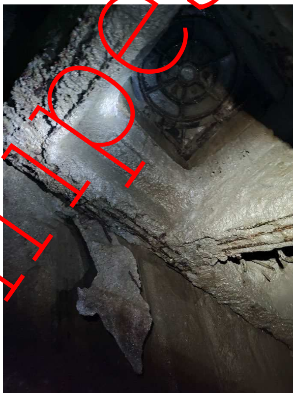
Foto 1. Beton exfoliat din placa de suprabetonare - armatura corodata expusa umiditatii
