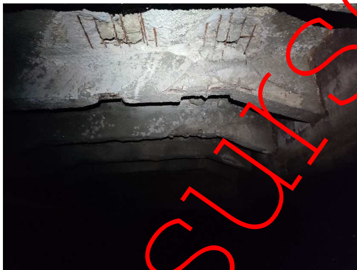
Foto 1. Beton exfoliat din placa de suprabetonare - armatura corodata expusa umiditatii
