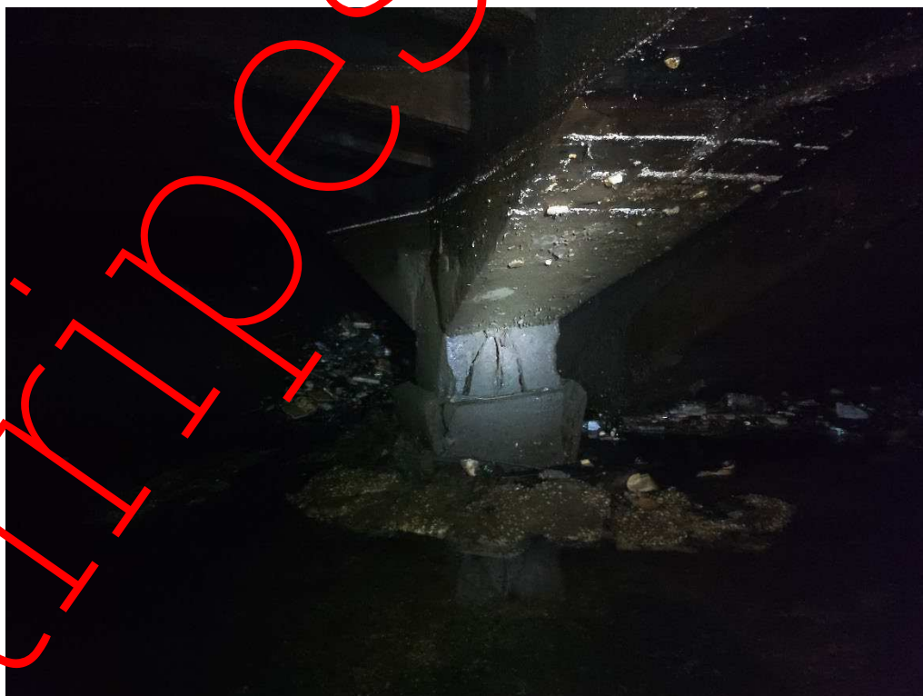
Foto 7 – Zona de placa distrusa, armatură din ancoretoaze complet expuse
